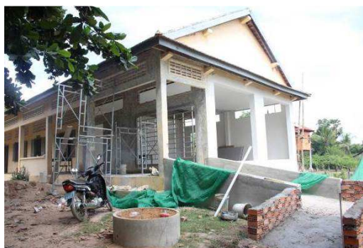
Construction d'une rampe d'accès pour les personnes handicapées
