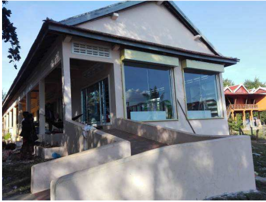
Installation finalisée de la bibliothèque
