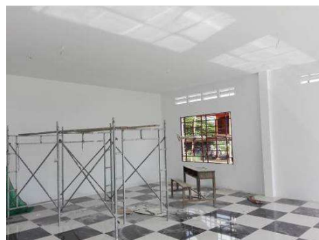
Finalisation de la rénovation du bâtiment
